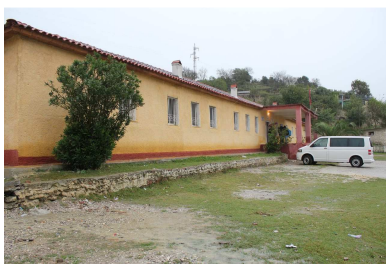
Total renoviert: Oberstufe & Gymnasium
